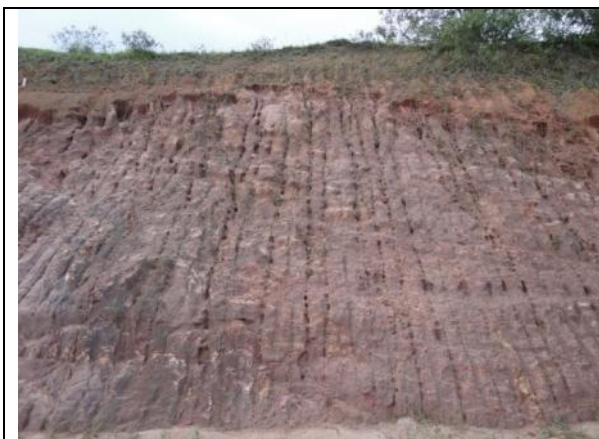
Foto V.3.5.5-1 - Porção sudoeste da All. Corte de encosta. Rod. RJ-108 – Bairro Parque Aeroporto. Exposição de solo eluvial derivado de xistos do Complexo Búzios. Instalação de processo erosivo na forma de sulcos superficiais.
