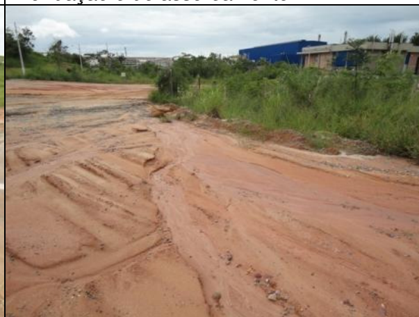
Foto V.3.6.2-10 – Porção oeste do TECAB. Processo de carreamento de solo erodido na encosta lateral e deposição dos materiais de assoreamento na margem esquerda da drenagem. Corte da encosta e conformação topográfica local indicam que o aterro executado avançou sobre a várzea da drenagem.
