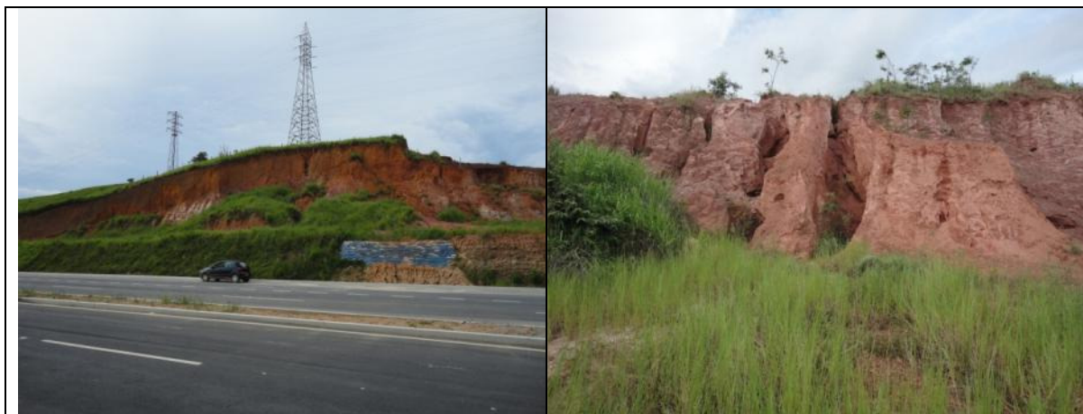
Foto V.3.6.2-3 - Porção sudoeste da All. Corte de colina próxima à avenida de integração da Rodovia RJ-108 – Bairro Parque Aeroporto. Exposição de solos de xistos do Complexo Búzios. Amplos processos de instabilidade, com predomínio de escorregamentos sucessivos. Execução de contenção com sacos de solo-cimento na base do corte. Possibilidade de erosão remontante e de novos escorregamentos, com instabilidade da torre de Alta Tensão.
