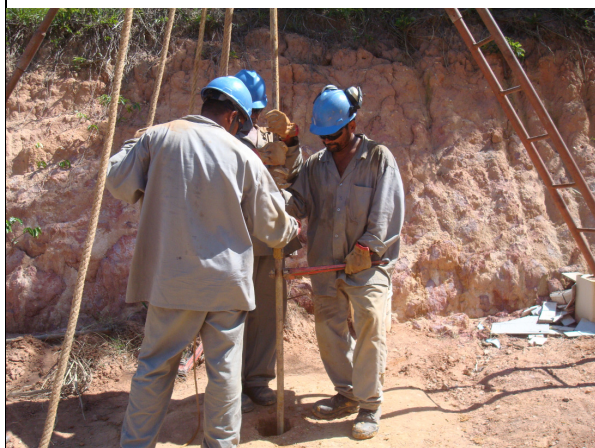
Foto V.3.8-1 - Procedimento de Sondagem para coleta de amostras de solo.
