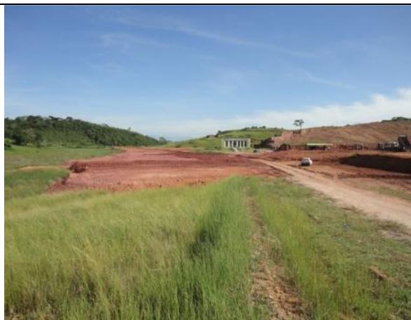
Foto V.3.6.2-7 - Porção sudoeste da All. Implantação de condomínio de baixa renda. Terrenos da várzea parcialmente aterrados, o que tende a potencializar a suscetibilidade aos processos de inundação e assoreamento, além de recalques localizados sobre solos moles.
