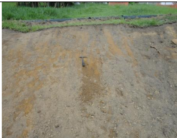
Foto V.3.4.3-15 - Vista de corte recente em encosta de colina ampla no interior do TECAB, na sua porção sudeste, além dos limites da Área de Ampliação do Empreendimento. Exposição de colúvio constituído por solo argilo arenoso marrom amarelado (ocre) homogêneo.
