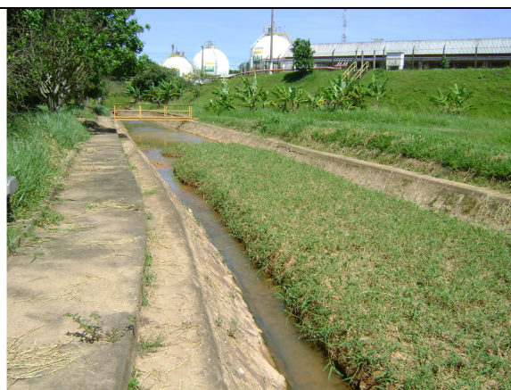
Foto V.3.10.1-6 – Vista da "Calha Principal de Drenagem" no interior da área do TECAB revestida por gramíneas em grande parte de seu curso.
