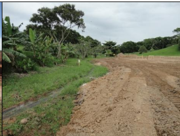
Foto V.3.6.2-8 – Porção sudeste do TECAB. Execução de terraplenagem na região da várzea de uma drenagem secundária. Corte parcial da encosta/colúvio e avanço do aterro lançado sobre a várzea. cupação parcial da área de várzea com canalização da mesma e restrição da sua seção hidráulica. Aumento da suscetibilidade aos processos de inundação e de assoreamento.
