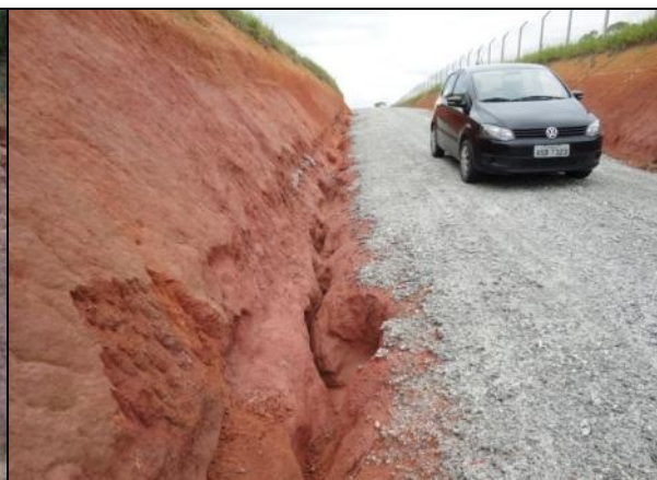
Foto V.3.5.5-2 – Porção norte da AID. Estrada vicinal interna do TECAB. Instalação de sulcos erosivos profundos. Erosão instalada sobre solo residual (eluvial) derivado de xistos do Complexo Búzios.
