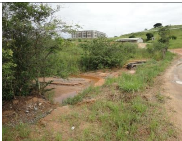
Foto V.3.6.2-9 - Porção oeste do TECAB. Estrada vicinal (continuação da via Perimetral) instalada sobre a várzea da drenagem principal que atravessa o Terminal. Avançado processo de assoreamento sobre a várzea e a drenagem.
